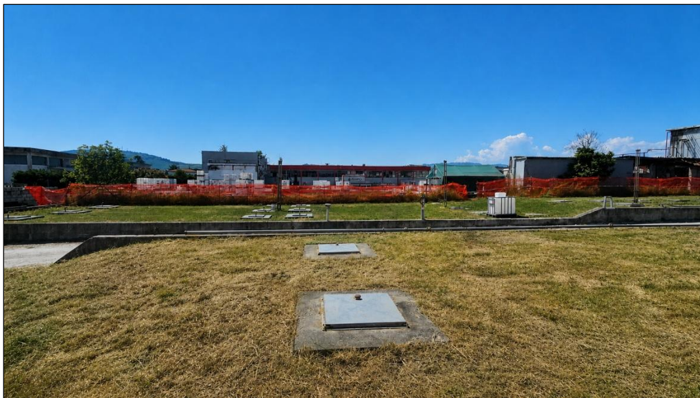
Fig. 2 – Panoramica dell'Area 1 - GPR 1.
