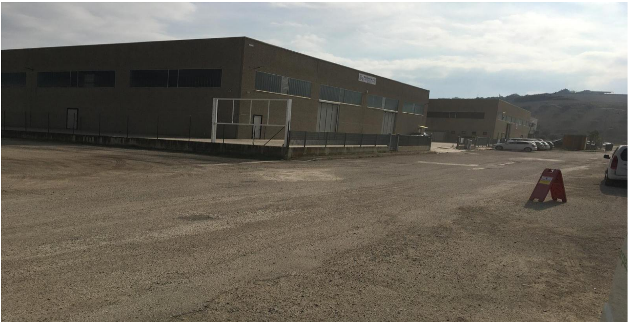
Fig. 4 Strada non asfaltata accanto al laboratorio mobile
