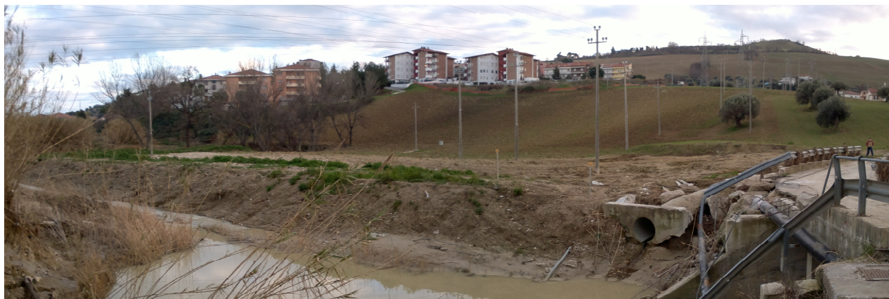
Figura 8.10 (Foto 6): Alluvioni recenti presso il torrente Calvano.
