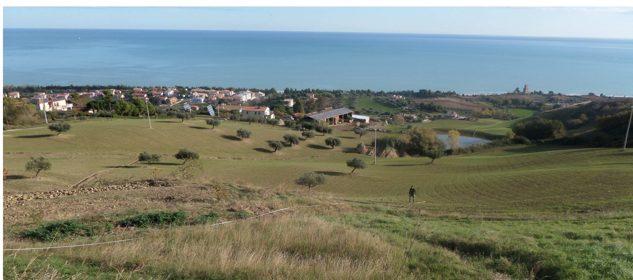
Figura 8.17 (Foto 16) - Panoramica verso Est, il corpo di frana.
