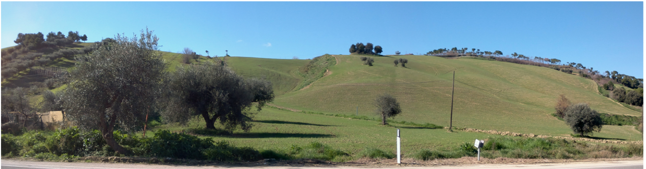
Figura 8.11 (Foto 4) - Frana rototraslativa lungo la SS16.
