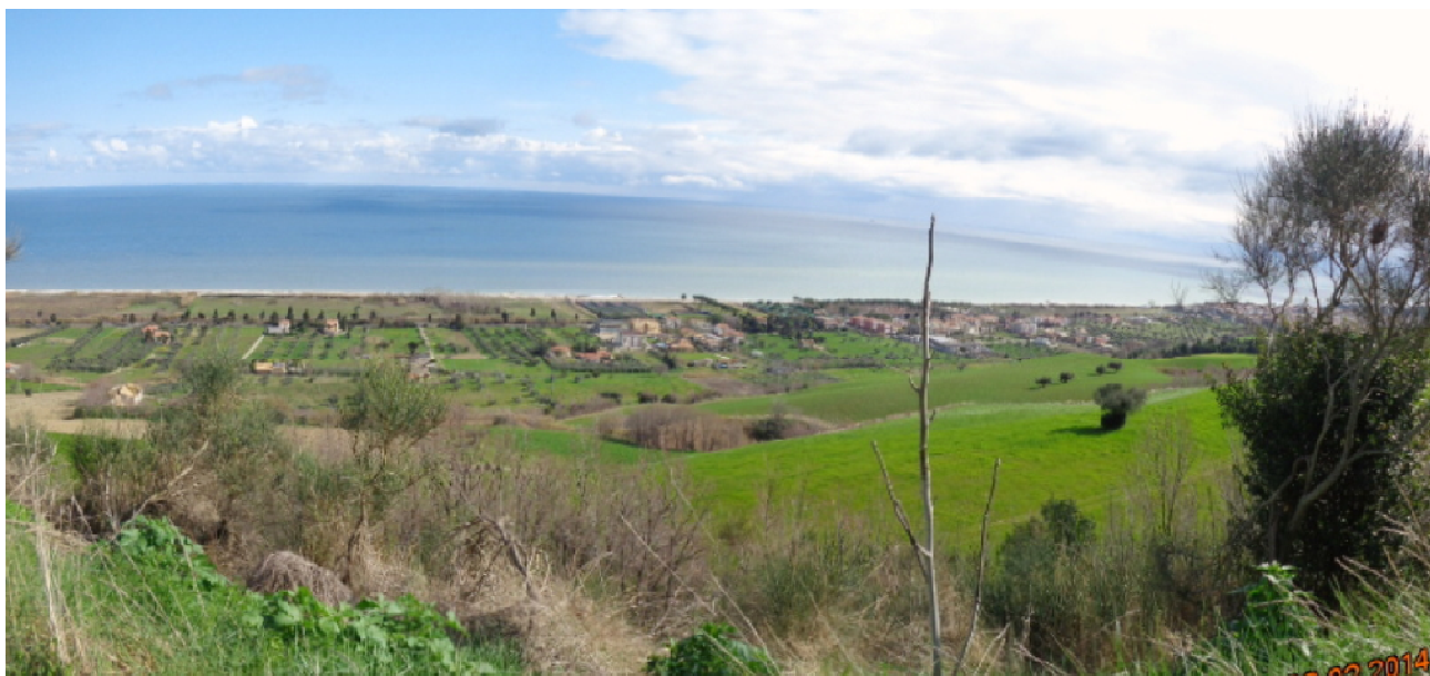
Figura 8.14 (Foto 11) - Frana Colle Morino, visuale dalla scarpata di frana verso NE
