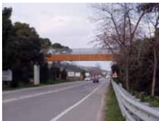
Figura 5.5. Cavalcavia di collegamento con il Parco Filiani
