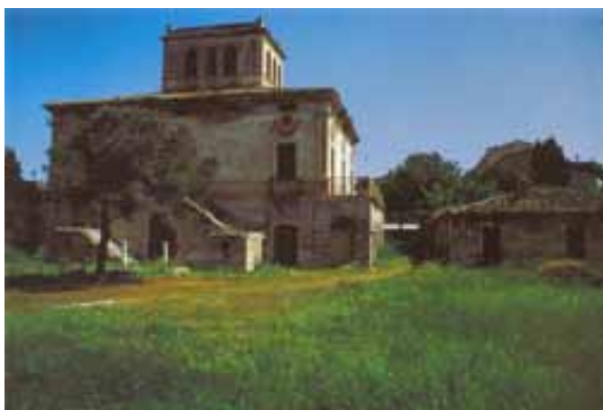
Figura 5.2: Villa Filiani prima del restauro
