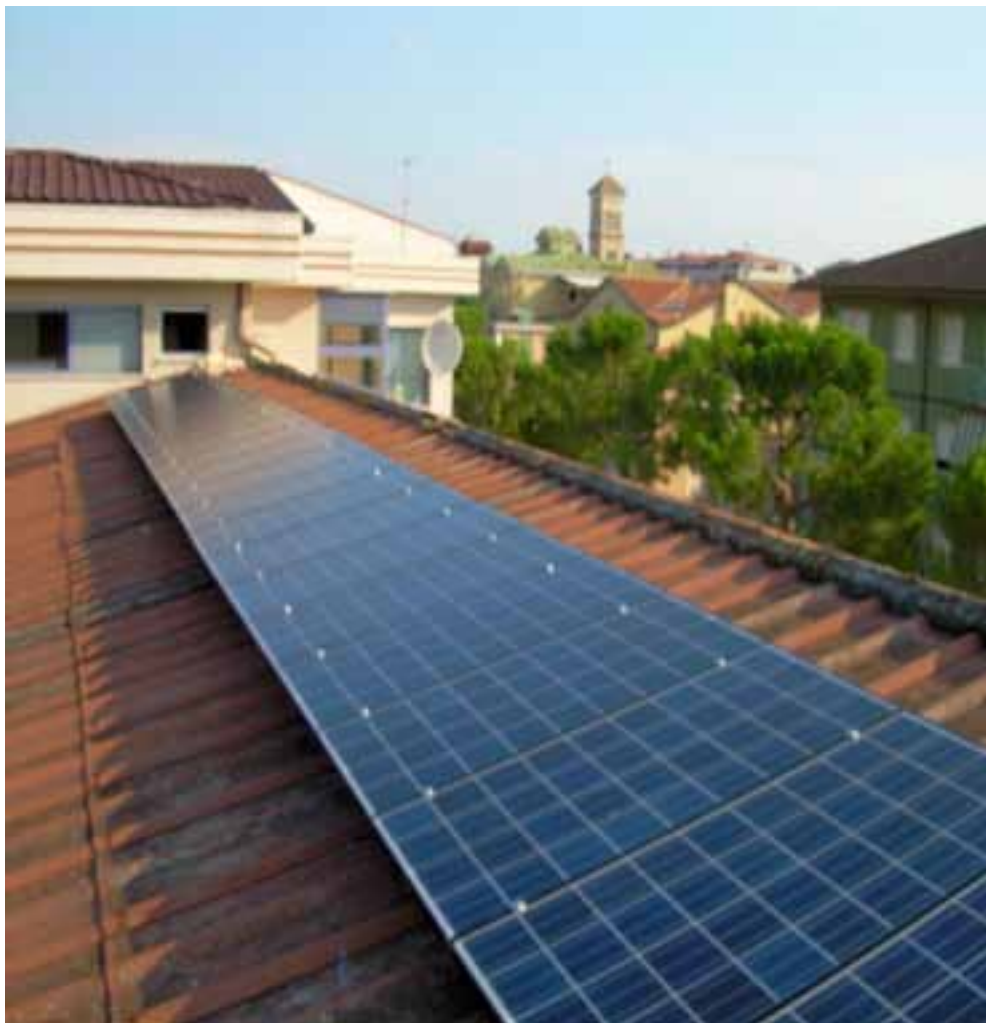
Figura 5.1. Particolare del tetto oggetto dell'intervento
